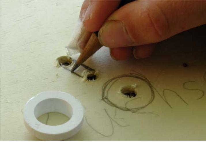
Langloch anzeichnen (die beiden 7 mm Löcher verbinden)
